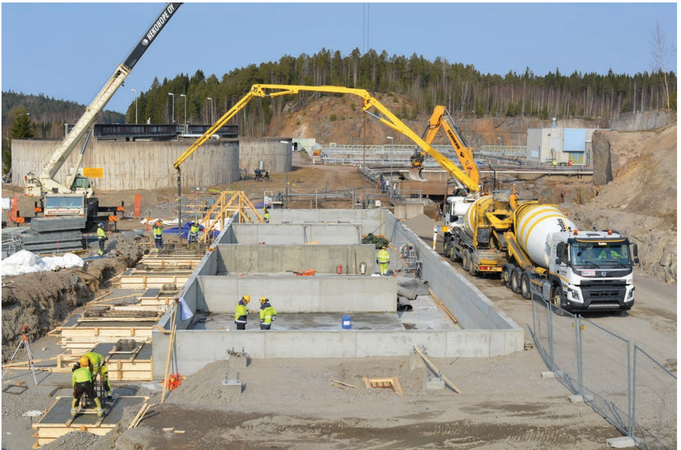
Biologiselle jäteveden puhdistamolle rakennettavat jäteveden jäähdytystornit valmistuvat kesällä. Tornien perustustöitä tehtiin maaliskuussa.
