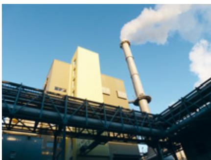
La chaudière biomasse produit de l'électricité verte en maîtrisant ses émissions dans l'air. Ceci s'opère par l'utilisation de biocombustibles qui alimentent la chaudière, ainsi que par l'épuration des fumées.
