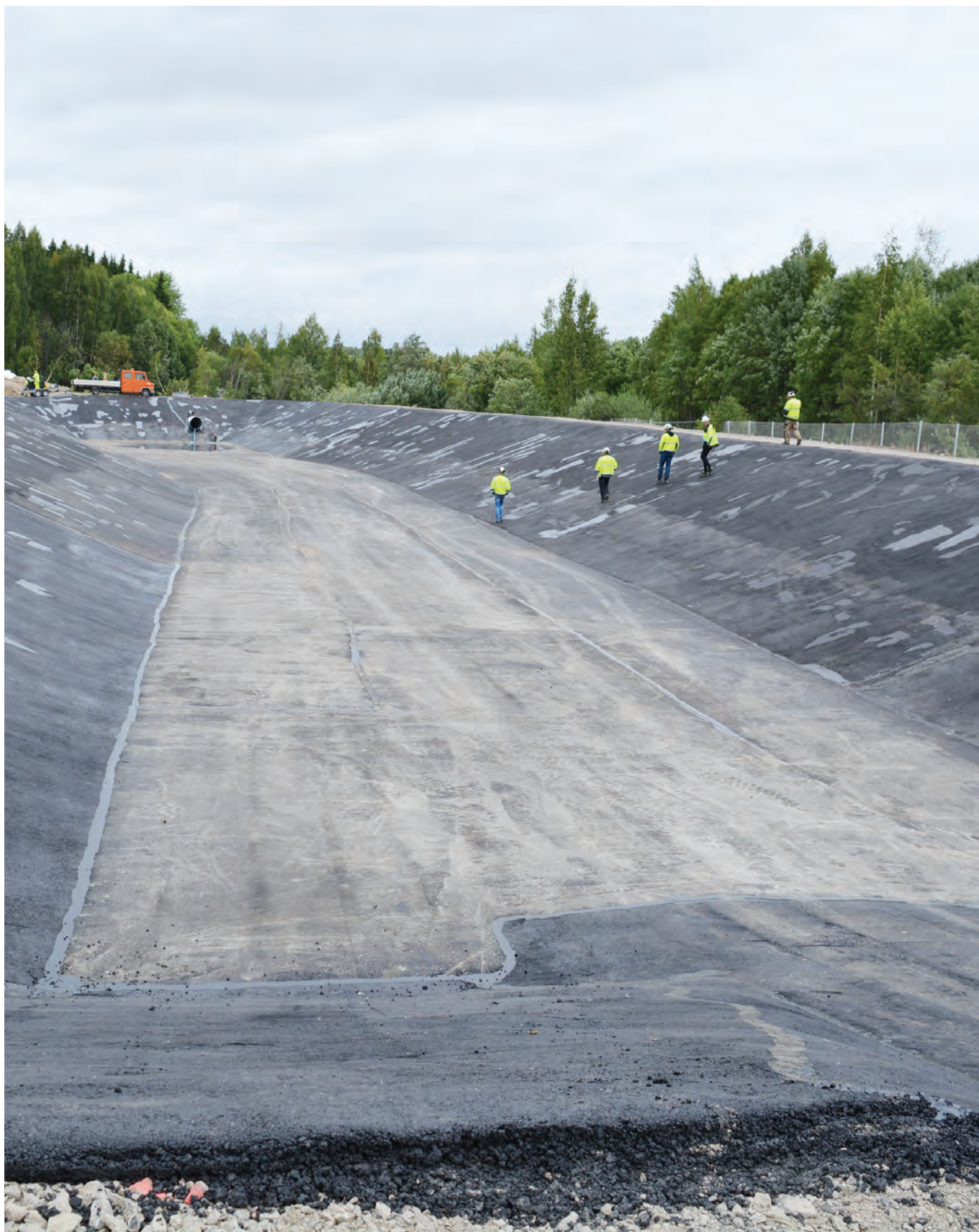
Syksyllä 2018 valmistuneen hulevesialtaan ansiosta huleveden mukana kulkeutuva kiintoaine kuten puun ja kuoren hienoaines jää altaaseen, mikä vähentää Kymijoen ravinnekuormitusta. Pituutta altaalla on 140 m ja leveyttä 30 m, syvyyssvaihtelu on 3-4 metriä. Tilavuudeltaan allas on noin 5000 kuutiometriä.
