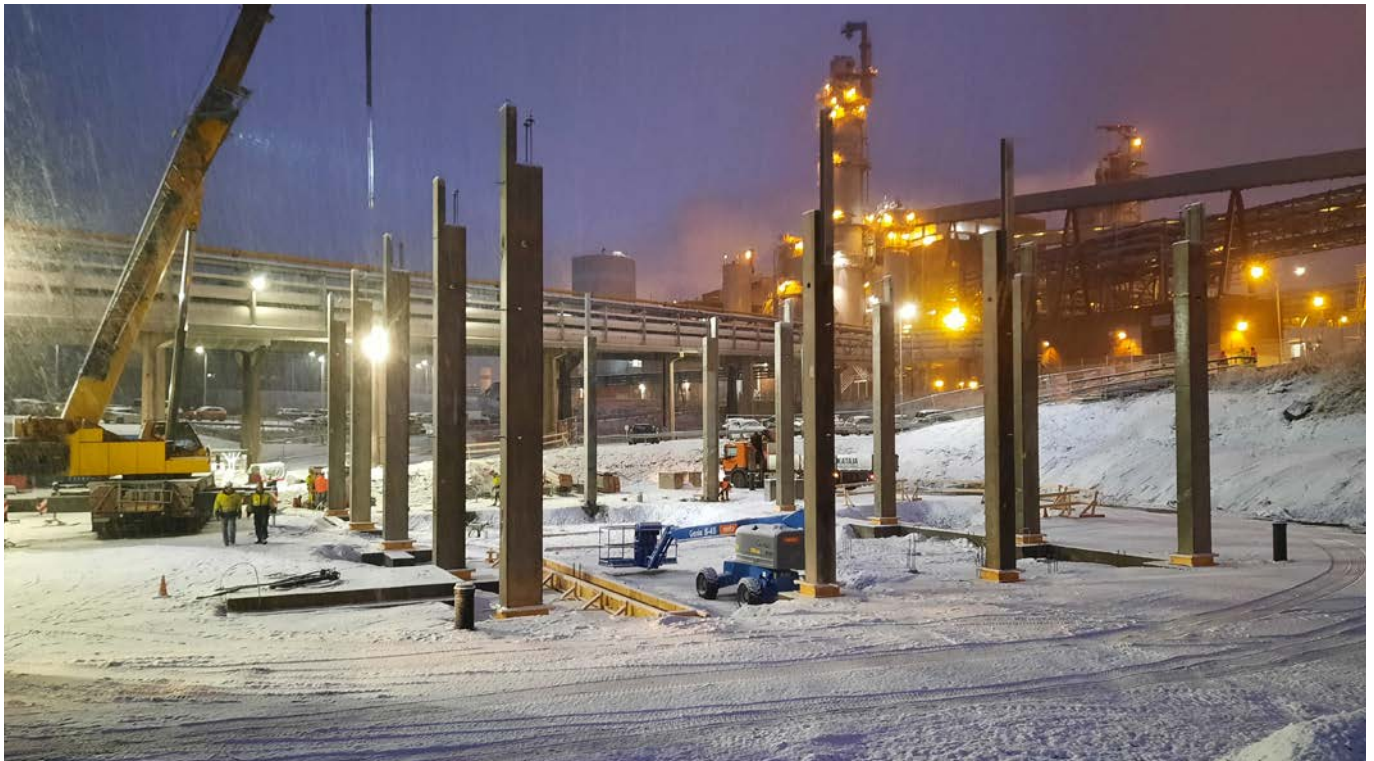
Kymin sellutehtaan uuden happilaitoksen rakennustyöt käynnistyivät syksyllä 2020. Kuva: Petteri Metiäinen
