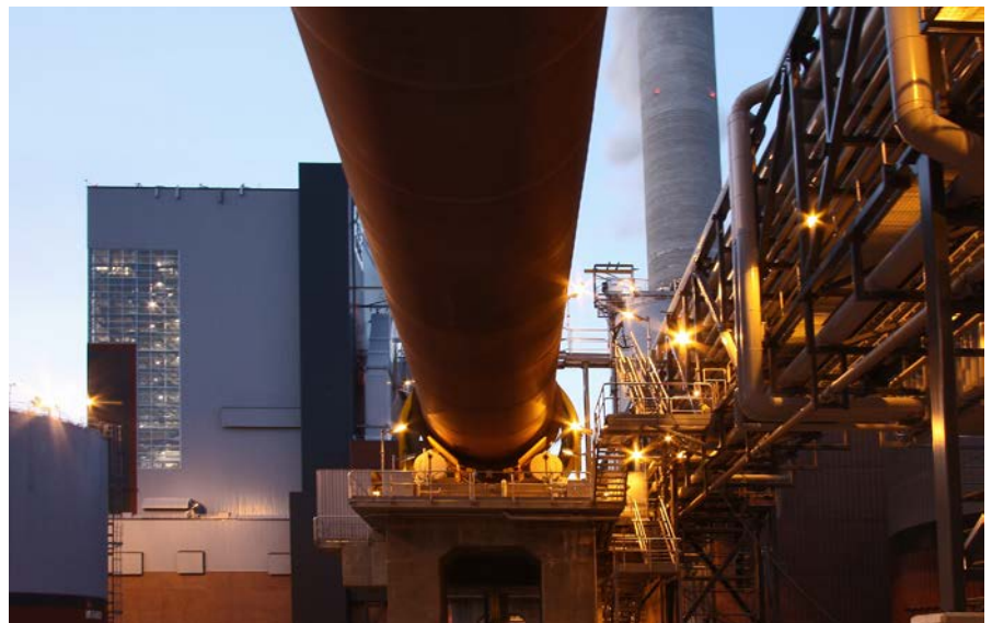
Kuvassa keskellä oleva sylinterin muotoinen meesauuni on tärkeä osa tehtaan kemikaalikiertoa. Meesauunin sähkösuodinkapasiteettia lisätään 2021 kunnossapitoseisokissa, jotta hiukkaspäästöt vähenevät.
